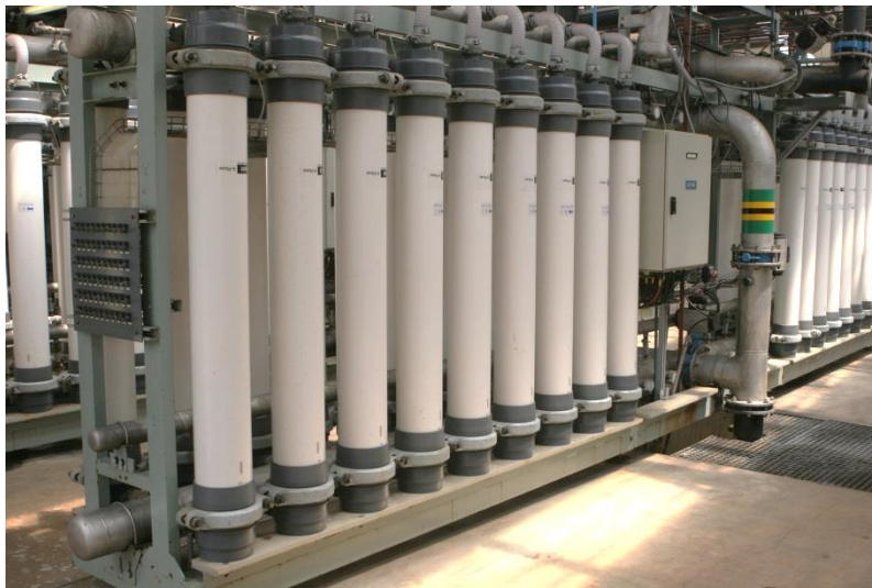
Abbildung 37: Ultrafiltrationseinheit der Grubenwasserreinigungsanlage eMalaheni in der Provinz Gauteng/Südafrika.
