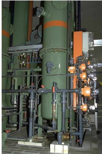
Abbildung 44: Industrieller Ionenaustauscher zur Abwasserbehandlung aus der Kupferelektrolyse in den Montanwerken Brixlegg/Tirol.
