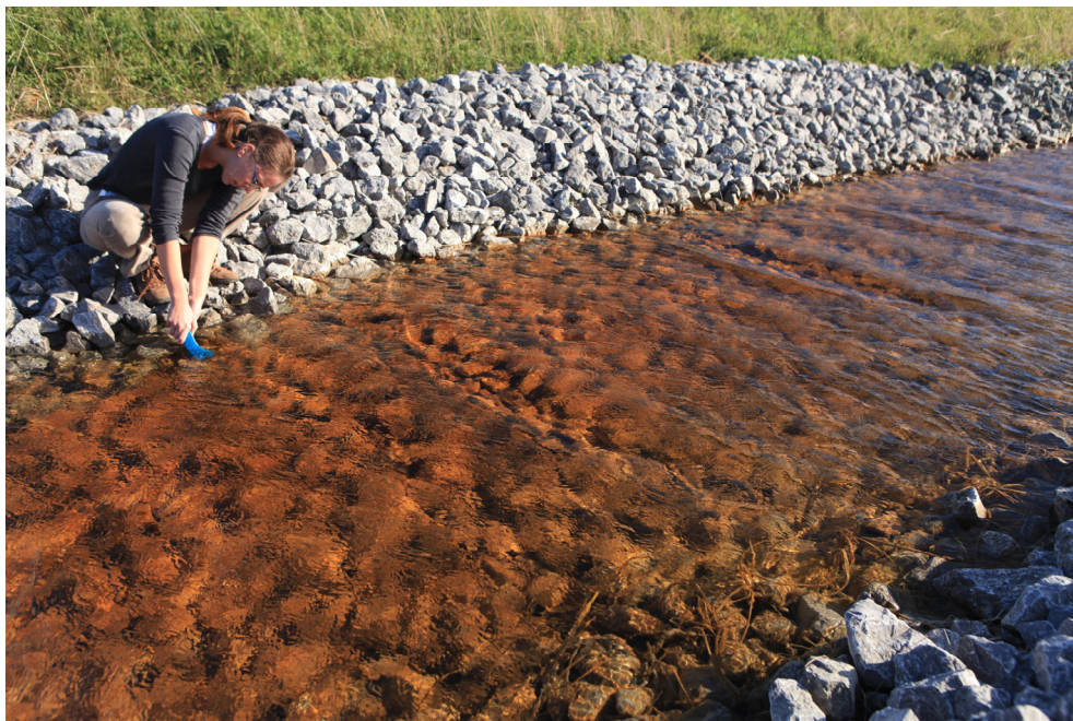
Abbildung 51: Offener Karbonatkanal mit Eisenhydroxidausfällungen am Grubenwasser-austritt des ehemaligen Kohlenbergwerks Dominion No 11 auf der Cape Breton Insel, Neuschottland, Canada.
