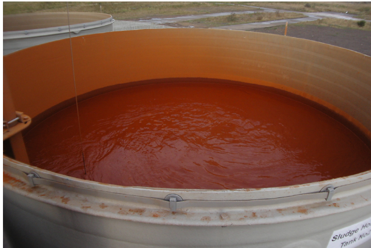
Abbildung 33: Schlammstammeltank der ehemaligen aktiven Grubenwasserreinigungsanlage Horden (County Durham, England).
