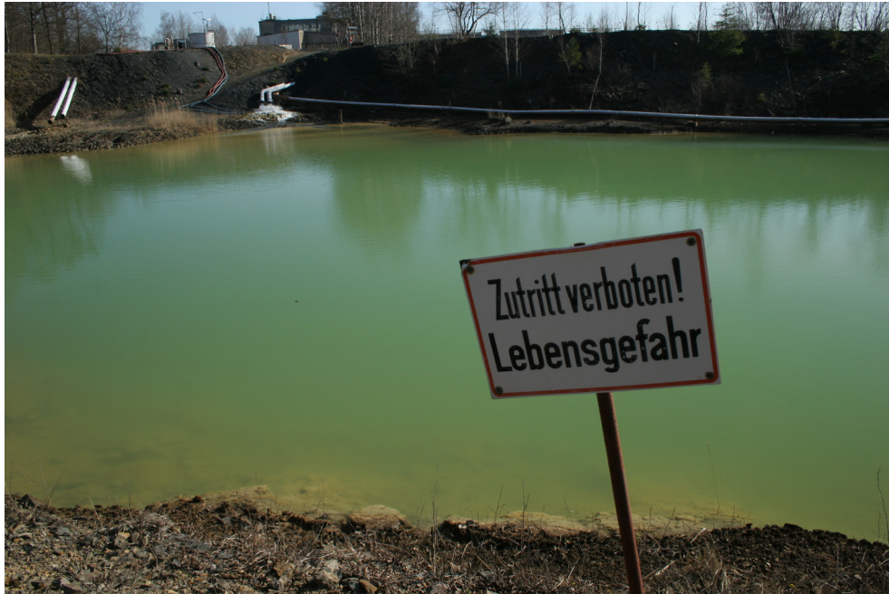
Abbildung 56: Absetzteich an der ehemaligen Grubenwasserreinigungsanlage Straßberg/Harz. Die Grünfärbung wird durch suspendierten Kalk.
