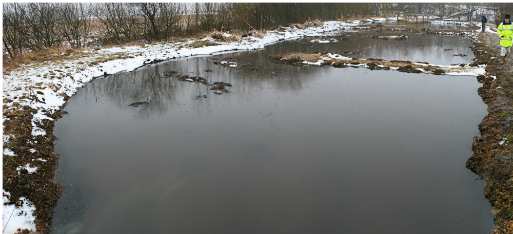
Abbildung 54: Erstes europäisches anaerobes konstruiertes Feuchtgebiet Quaking Houses (County Durham, England, Vereinigtes Königreich). Pflanzenbewuchs fehlt, da der Schlamm nach 10 Jahren Betriebszeit ausgetauscht worden war.
