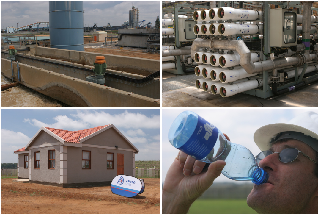
Abbildung 72: Grubenwasseraufbereitungsanlage eMalaheni. Von links oben nach rechts unten: Vorreinigung (im Hintergrund links das Laugenbecken und rechts die Kohlenmine); Umkehrosmose; Gebäude aus Gips; in der Anlage hergestelltes Mineralwasser (Provinz Gauteng/Südafrika).
