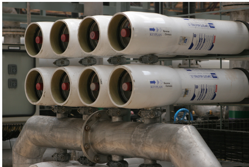
Abbildung 38: Umkehrosmoseeinheit der Grubenwasserreinigungsanlage eMalaheni in der Provinz Gauteng/Südafrika (vgl. Abbildung 72).
