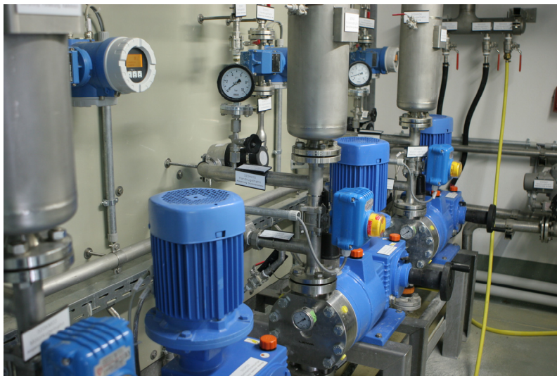
Abbildung 25: Pumpen für die Chemikalienzufuhr in einer aktiven Grubenwasserreinigungsanlage (Straßberg/Harz).
