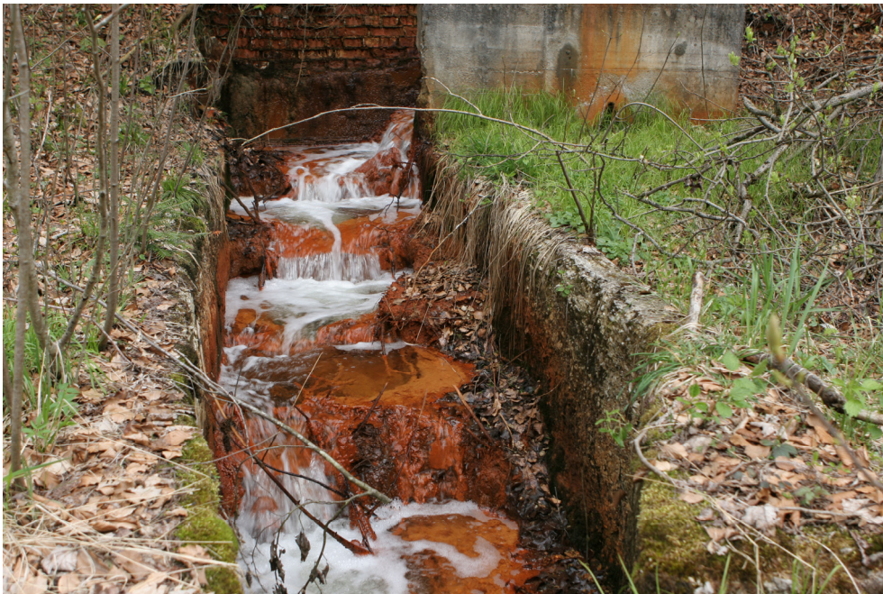
Abbildung 57: Oxidationskaskade des Ventilatorstollens an der Leitzach, Oberbayern. Durchfluss etwa 2 m 3 /min. Breite des Kanals etwa 1 m.
