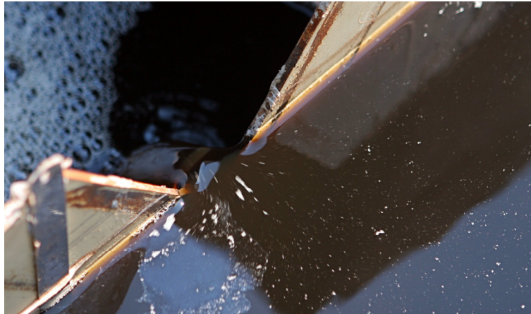
Abbildung 15: Falsch installiertes Messwehr an der IMPI Pilotanlage Middleburg in der Provinz Gauteng, Südafrika. An der Wehrplatte fehlt die abgeschrägte, wasserseitige Ab-risskante.
