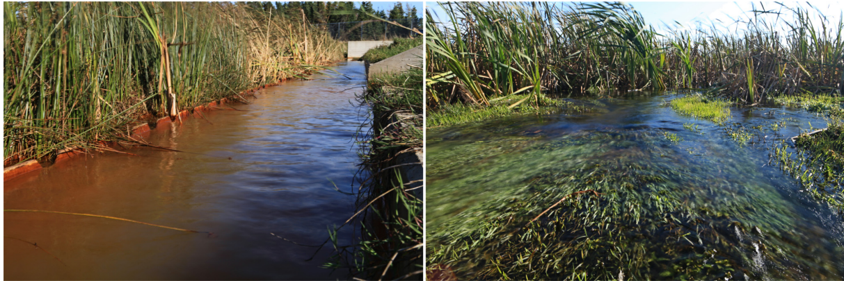
Abbildung 52: Zulauf (links) und Ablauf (rechts) des aeroben konstruierten Feuchtgebiets Neville Street (Cape Breton Insel, Neuschottland, Kanada). Das Wasser fließt verockert und metallreich in das konstruierte Feuchtgebiet (links) und verlässt es kristallklar und mit deutlich verminderter Metallfracht wieder (rechts).
