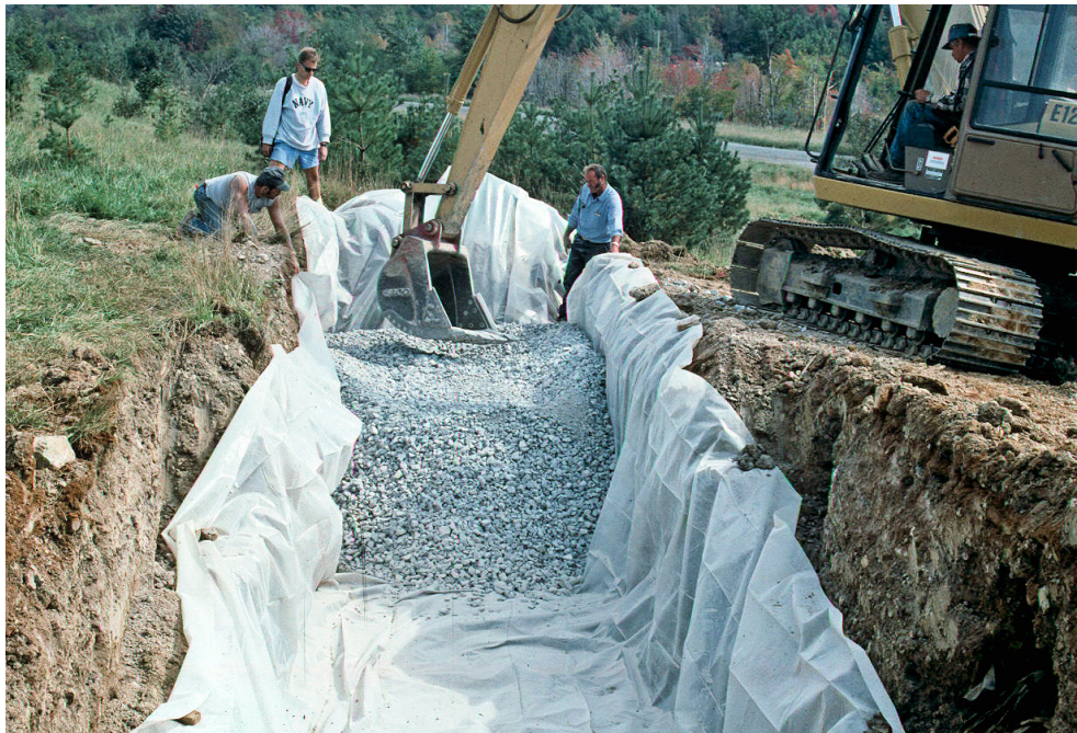
Abbildung 50: Anoxischer Karbonatkanal während der Konstruktionsphase (Foto: Jeff Skouson).
